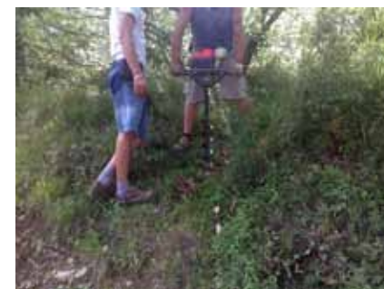
scavo nel terreno, dove si può si usa la trivella
