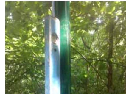
si verifica la verticalità del palo
