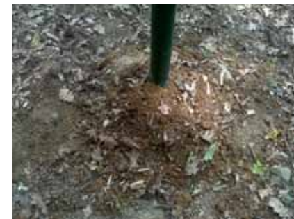
si lascia il più possibile pulito l'intorno del palo
