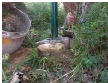
si realizza un basamento in cls e pietre di grosse dimensioni
