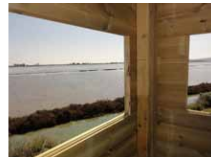
montaggio delle pareti e creazione delle aperture
