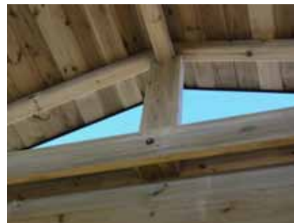
realizzazione della copertura impermeabilizzata
