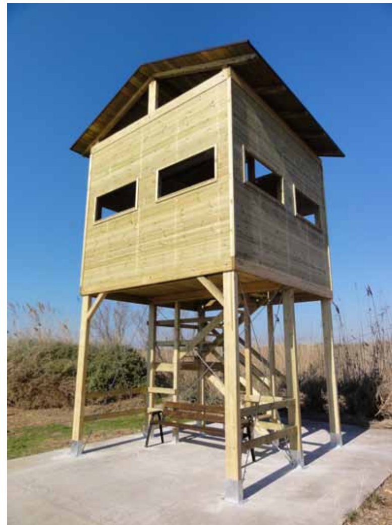
il capanno realizzato per il Parco Molentargius-Saline di Cagliari misura cm 350x350x650(H).
