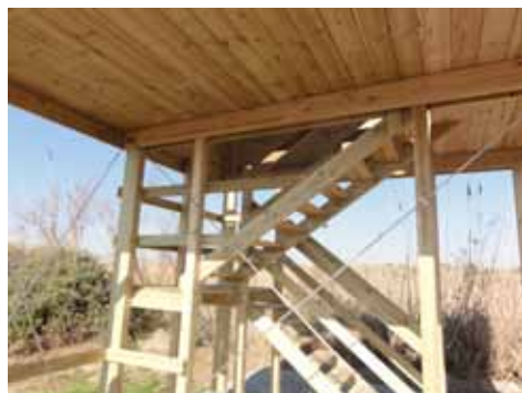
scala d'accesso con mancorrente
