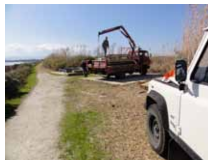
arrivo sul posto: operazioni di scarico
