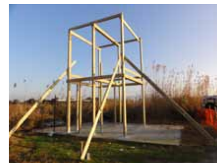
montaggio del telaio principale della struttura
