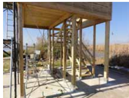
costruzione della scala d'accesso al piano
