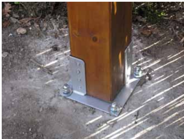
Staffa di ancoraggio al suolo imbullonata.
