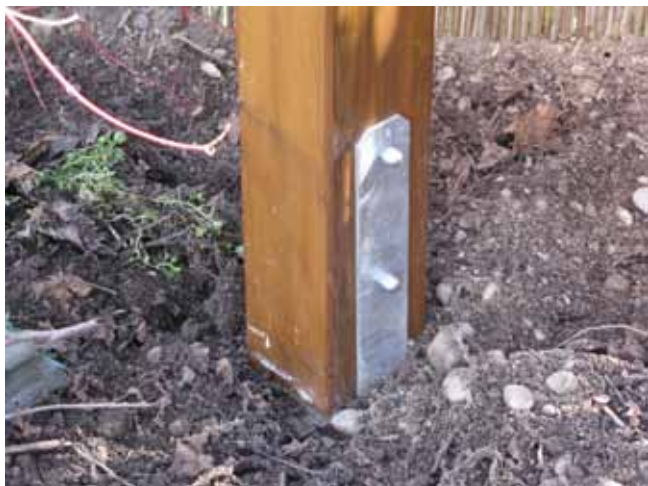
Staffa di ancoraggio al suolo interrata.
